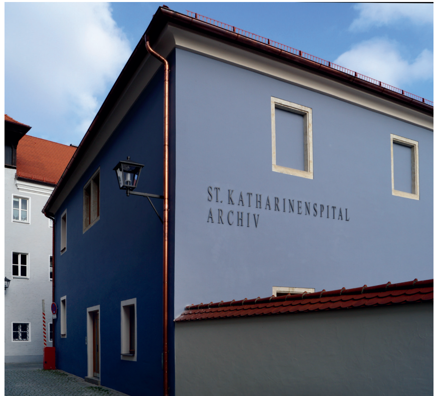
2c Das 2014 eröffnete neue Archivgebäude im denkmalgeschützten ehemaligen Braumeisterhaus der Stiftung, dessen älteste Bauelemente aus dem 16. Jahrhundert stammen. Hier findet ein großer Teil der Projektarbeiten statt. Quelle: Stadt Regensburg, Bilddokumentation.
