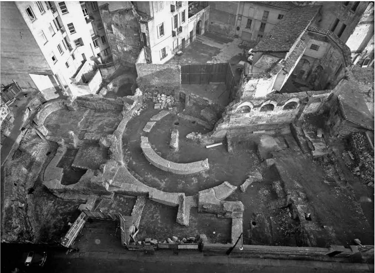
4 Luftbild des Reprasentationsbaus an der Via Brisa, der eventuell Teil des kaiserlichen Palastes war. Einige der Raume waren beheizbar und mit kostbaren marmornen Wandverkleidungen ausgeschmuckt.
