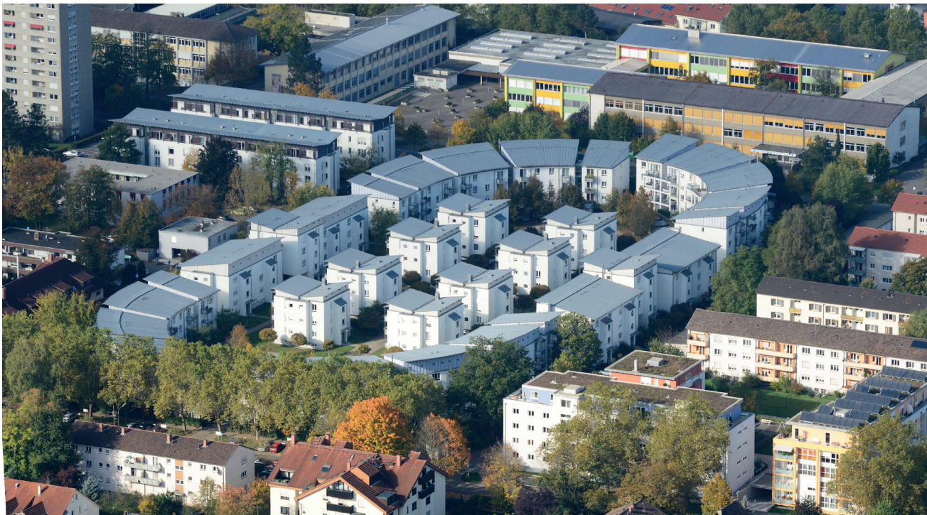
2 Luftbild der Wohnanlage „Stadion“ in Lörrach. Von Taxiarchos228 - Eigenes Werk, CC BY 3.0, https://commons.wikimedia.org/w/index.php?curid=22556281 .
